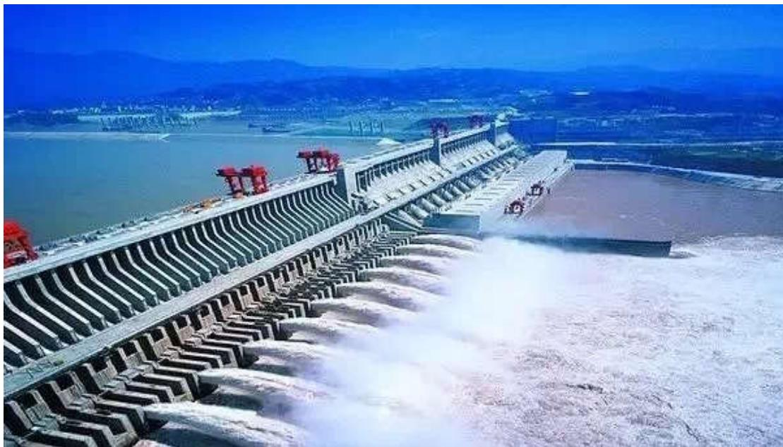
三峡大坝位于宜昌县三斗坪镇，下距葛洲坝 40 公里，整个工程由拦江大坝、水力发电厂和通航船闸组成，拦江大坝建在中堡岛上。三峡水利枢纽是综合治理与开发长江的关键性工程，三斗坪一带河床开阔，两岸花岗岩基坚硬、完整，所以长江三峡工程选址在这里。长江三峡工程竣工后，将发挥防洪、发电、航运、养殖、旅游、保护生态、净化环境、开发性移民、南水北调、供水灌溉等十大效益，其中年均发电量可达 849 亿度。
